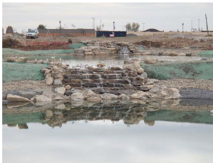
Cascade entre les deux lacs – oct. 2009
