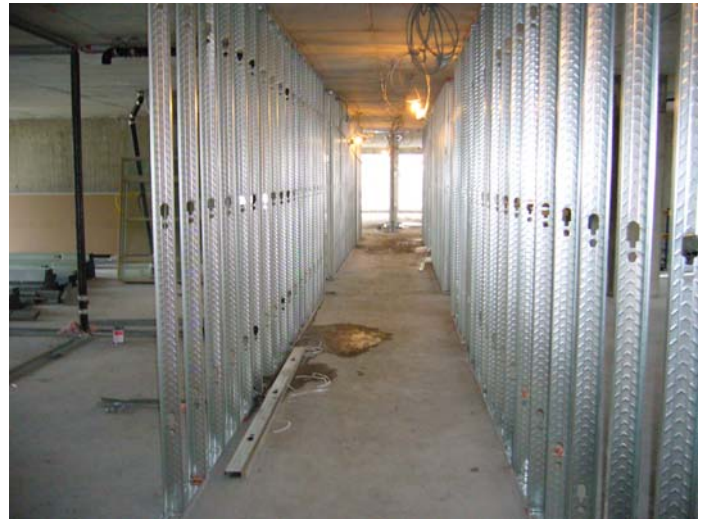
Corridor au 2 e étage – avr. 2009
