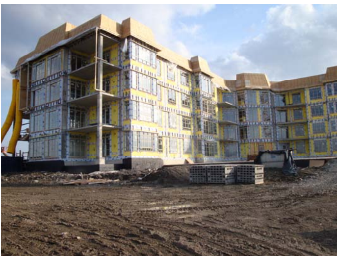
Installation des fenêtres complétée – mai 2009
