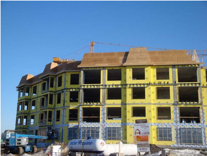
Complétion des mansardes du toit – avr. 2009
