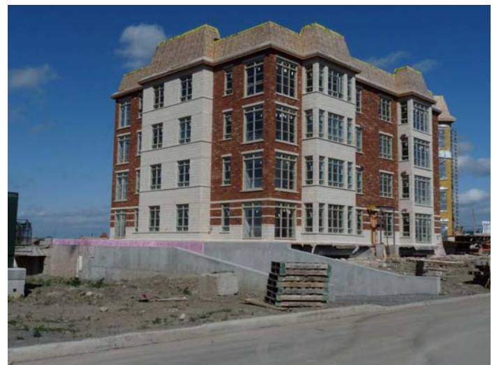
Maçonnerie en cours – juin 2009
