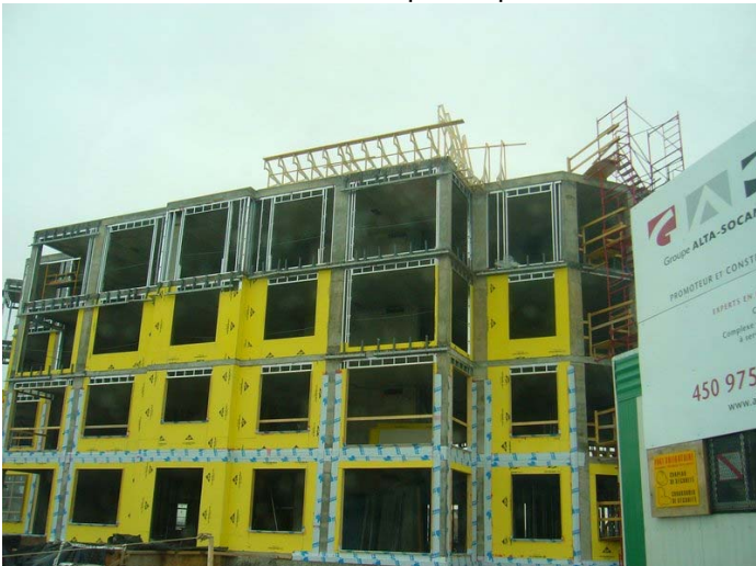
Installation de la structure des mansardes du toit – mars 2009
