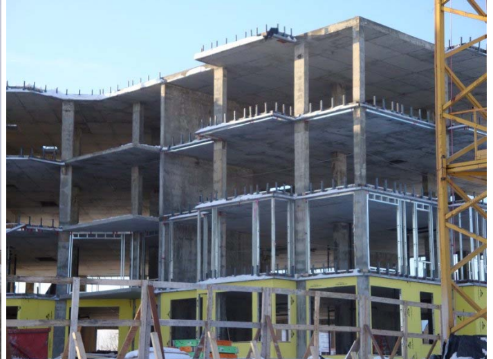
Montage des murs extérieurs – fév. 2009
