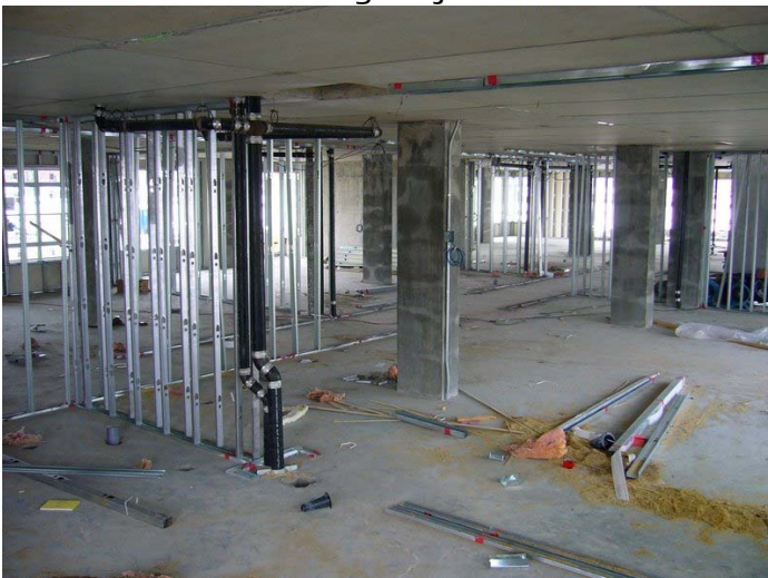
Installation des cloisons métalliques et plomberie – fév. 2009
