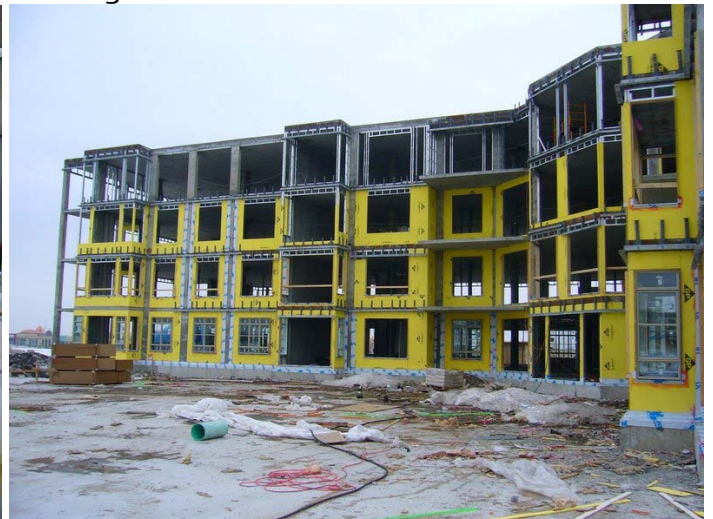
Début de l'installation des fenêtres au rdc – mars 2009
