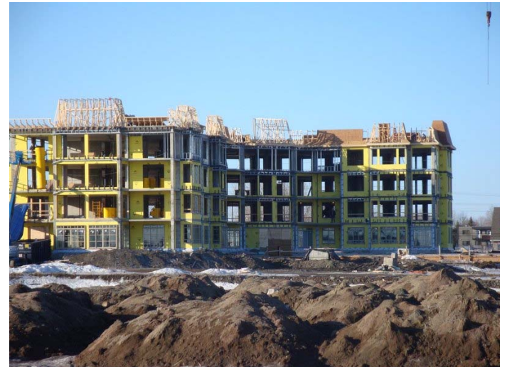
Installation de la structure des mansardes du toit – mars 2009
