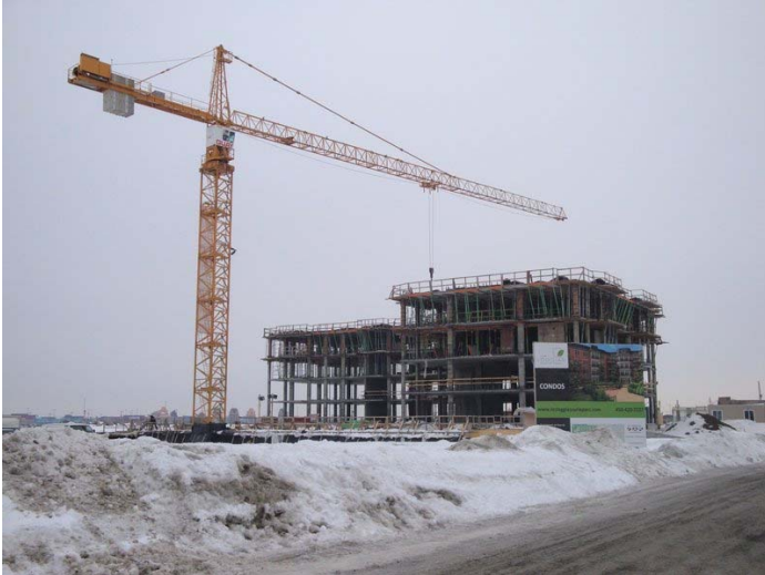
Béton coulé sur les 4 étages – janv. 2009
