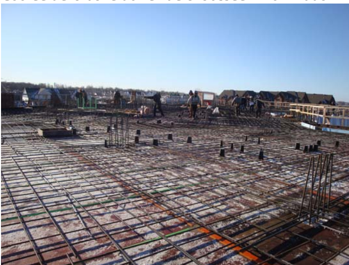
Armature installée au 2 e étage – déc. 2008
