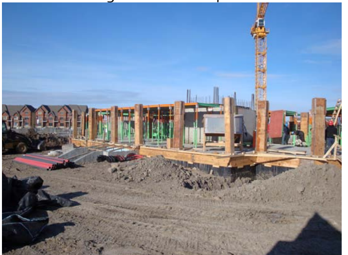
Installation du coffrage pour 2 e étage – nov. 2008
