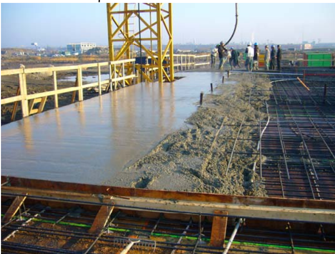
Coulée de la dalle du rez-de-chaussée – nov. 2008
