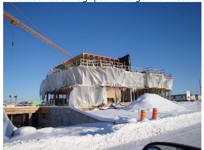
Dalle coulée / protection contre le gel – déc. 2008
